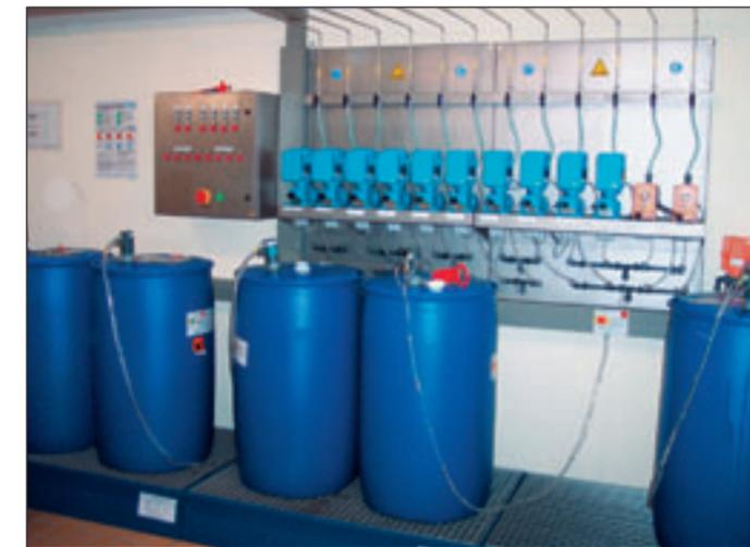
Bild 3: Zentrale Dosieranlage und Überwachung der Installation für optimale Wasserqualität.
