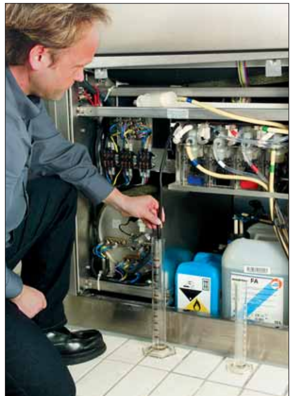
Abbildung 1: Prüfung der Volumendosierung
