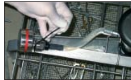
Abbildung 12: Schritt VII: Druck-/Temperaturlogger mit einem Kabelbinder fixieren (sowohl der Logger als auch der Kabelbinder dürfen unter keinen Umständen in den Bereich des Spülarms gelangen).
