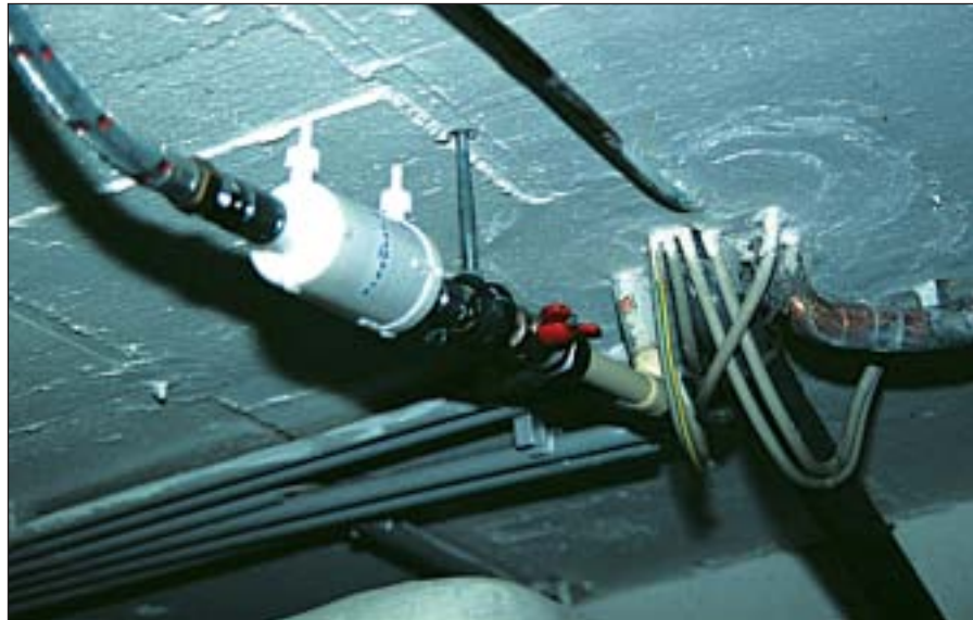
Abb. 1: Einbau des Filtersystems in die Wasserzuleitung zur Dentaleinheit direkt unter deren Basisteil.
